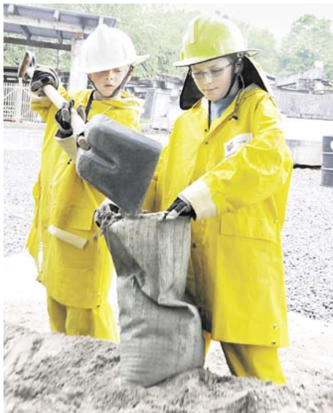
Sandsäcke abfüllen für den Hochwasserschutz.
